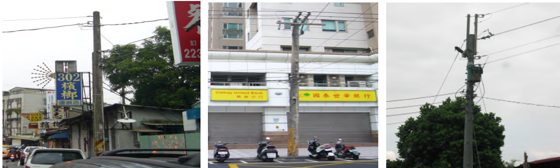
圖 2-3 電桿型支持物
